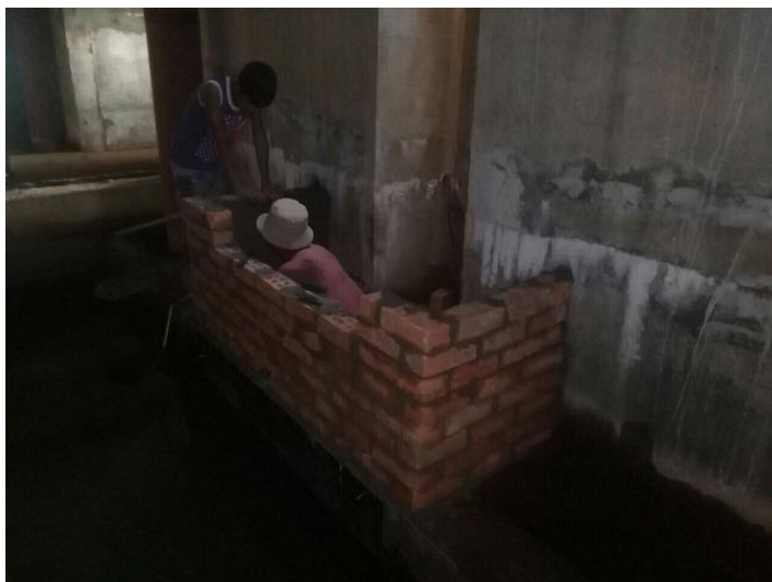
流出堰のかさ上げ工事
