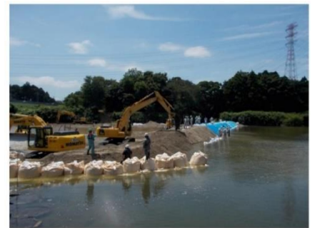
久慈川の土堰堤築堤作業
