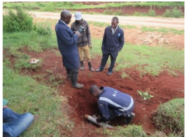
写-1 超音波流量計で流量を測定する現場
