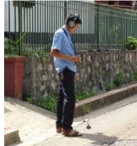
写 2 埋設管から発生する漏水音を地表面で捉える。
