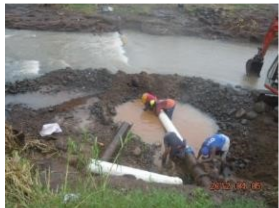
写4 水中での配管工事(漏水修理工事)
