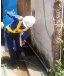
写 1 メーター・公道の栓・弁を接点として漏水の有無を調べる。
