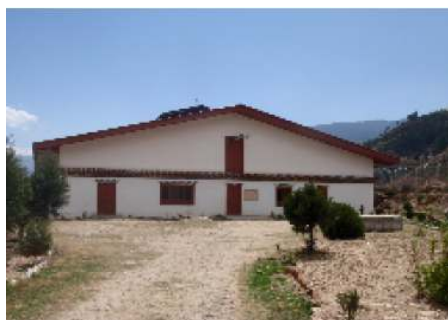
DANIDA 資金提供の緩速ろ過施設
