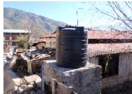
各家庭には貯水タンクがある所々
