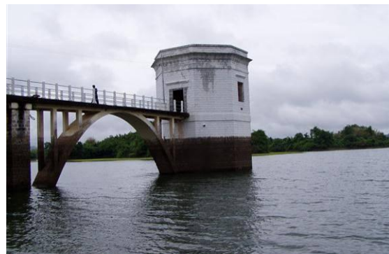
水源地 取水塔(ヤンゴン)
