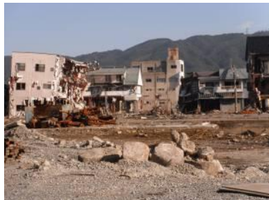
破壊された街（気仙沼）
