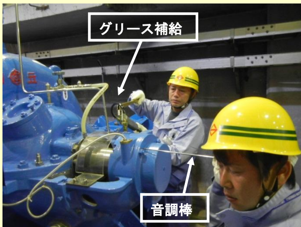
音調棒を使用した軸受の異音チェック
