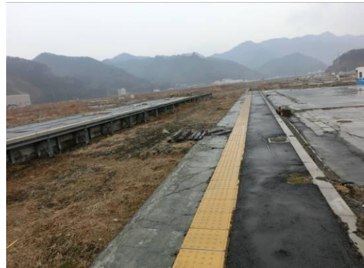
大槌駅の跡、JR 山田線の復旧は進んでいない
