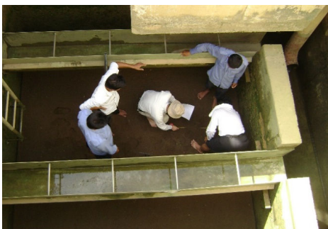
フェーズ2におけるろ過池砂層調査 OJT (バタンバン浄水場)
