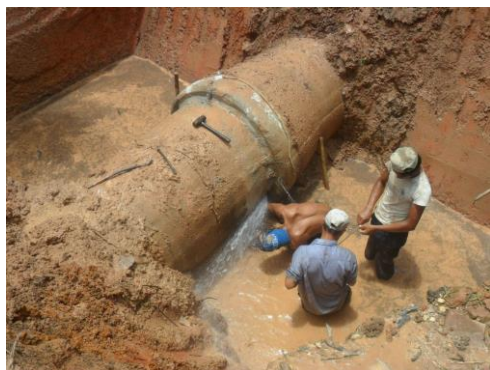
写真-3 送水管の漏水修理中
