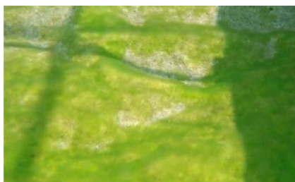
写真2: 緩速ろ過池(B)表層
