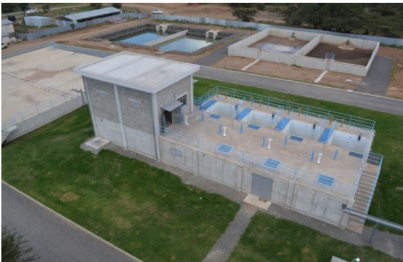
JICA「ナロック給水拡張計画」で作られた浄水場
