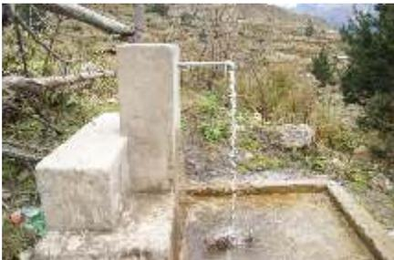
このデザインは中央政府が作成し各県に指導し設置しています。鋼管、継手、蛇口はインド製で、質は決して良いとは言えません。このデザインは1年を通して温暖な場所なら問題ありませんが高地で冬場零下になる場所では凍結し破損してしまいます。そこで、水道管が凍結しないよう国内で手に入る材料で寒冷地仕様の共用水栓をデザインしました。
