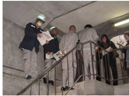
安養寺配水所内で被害の説明を受ける
