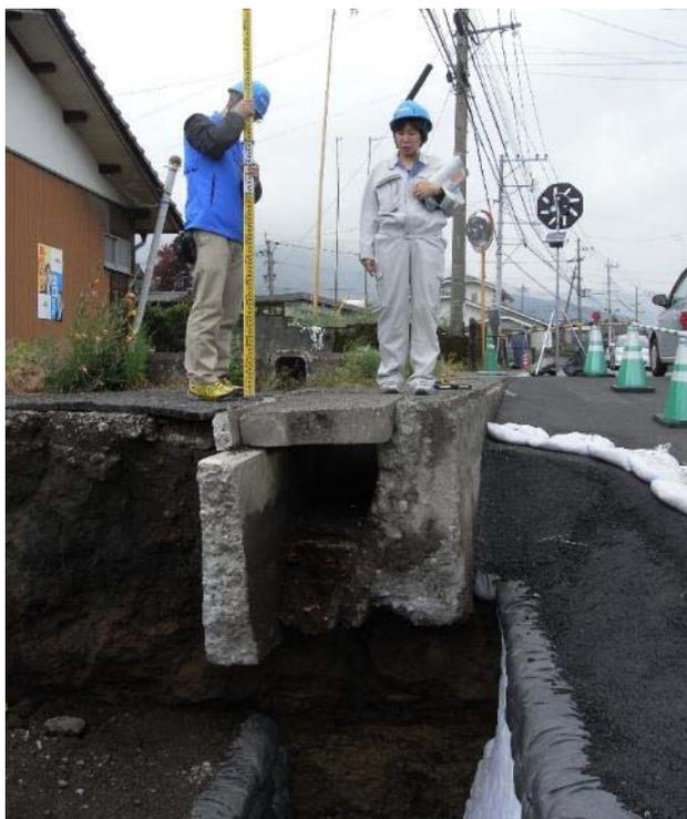
(上 2 枚)阿蘇市狩尾地区に現れた地表断層。県道 175 号線を横断し、幅約 40～50m、上下変位(陥没量)1.6～2.1m、断層延長は 1km に及ぶ
