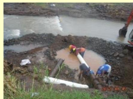
写4 水中での配管工事(漏水修理工事)
