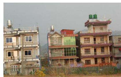
民家の屋上には水を確保するタンクが！
